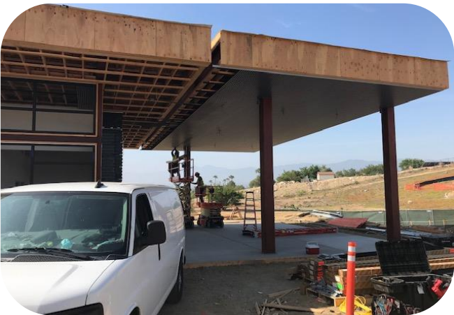
Linear Metal Ceiling
