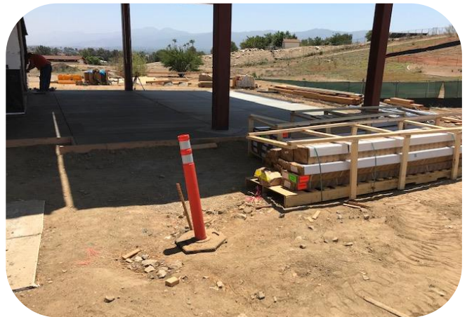
Patio slab poured.
